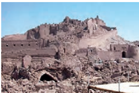
ارگ بام، بزرگ‌ترین سازه خشتی جهان در زلزله بام دچار تخریب زیاد شد.
