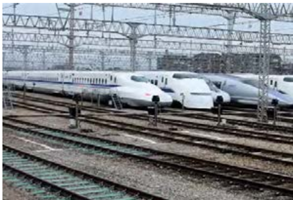
ایستگاه قطارهای پرسرعت - شینکازن - ژاپن
