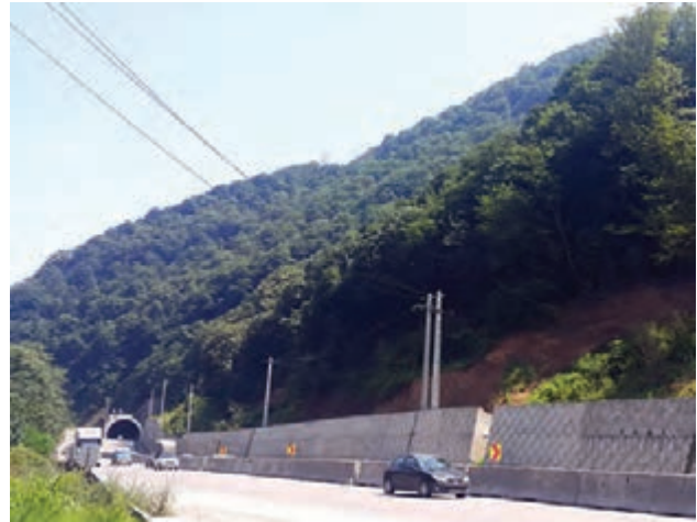
نصب حفاظ بتونی - جاده قائم‌شهر
