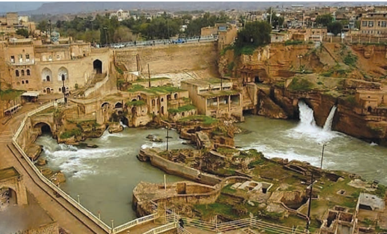
شکل ۵- سازه‌های آبی - تاریخی، شوشتر، خوزستان
