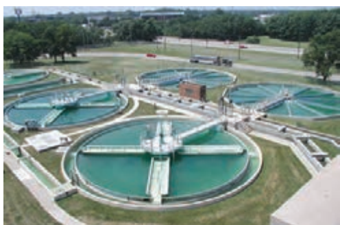
تصفیه آب در تصفیه خانه
