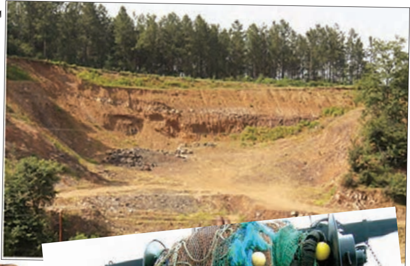
الف) تخریب زیستگاه
