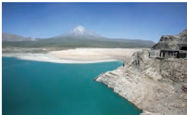
شکل ۷- سد لار در تهران، در مکان مناسبی احداث نشده است.
